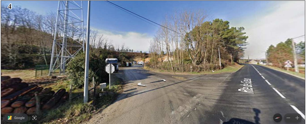
Vue depuis la RD 749 sur l'entrée du site
